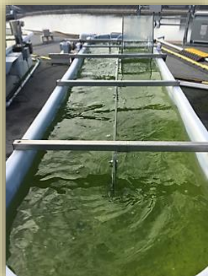
Za bioprečišćavanje otpadnih voda
